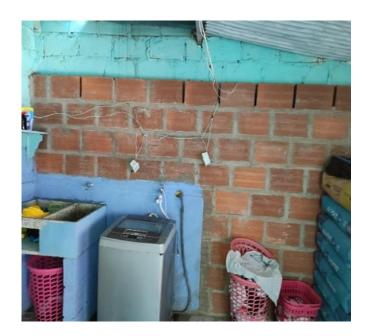
Muros sin pendiente para instalación de cubiertas y sin Vigas Canal para evitar la entrada de aguas Iluvias de las cubiertas.
