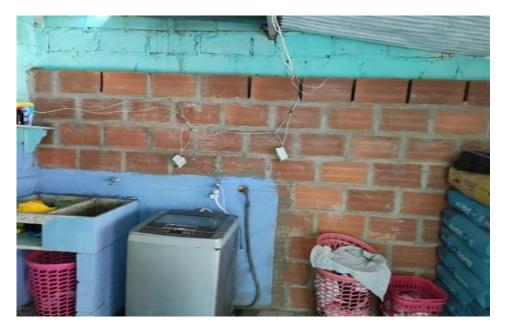
• Muros sin pendiente para instalación de cubiertas y sin vigas canal para evitar la entrada de agua lluvia de las cubiertas.
